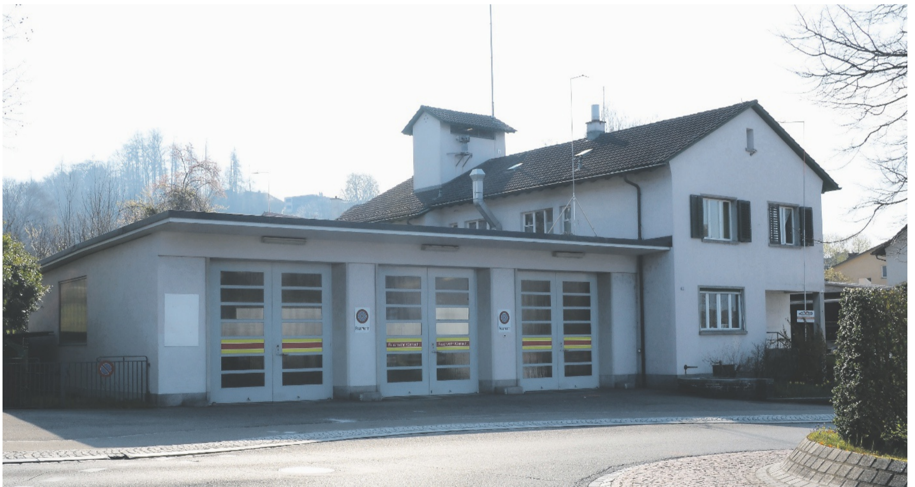
Geschichtsträchtiger Bau: Das heutige Feuerwehrdepot an der Alten Landstrasse wurde 1936 gebaut. Vor 45 Jahren wurden letztmals Anpassungen gemacht.
